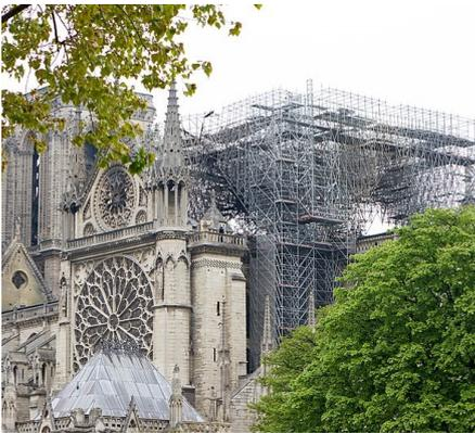
Le démontage de l'échafaudage calciné qui pesait sur la voûte de Notre-Dame de Paris est enfin terminé pour le plus grand soulagement des équipes du chantier de la cathédrale. La phase de consolidation va se poursuivre à l'intérieur avec la mise en place d'étais pour soutenir la voûte. « L'échafaudage est effectivement totalement retiré. Il ne reste que les quatre grosses piles mais elles
